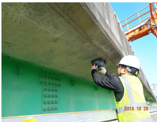
위 치 바닥판하면 내 용 철근탐사
