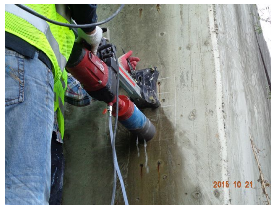
위 치 교대 내 용 코어 채취
