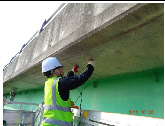
위 치 바닥판하면 내 용 초음파 강도시험
